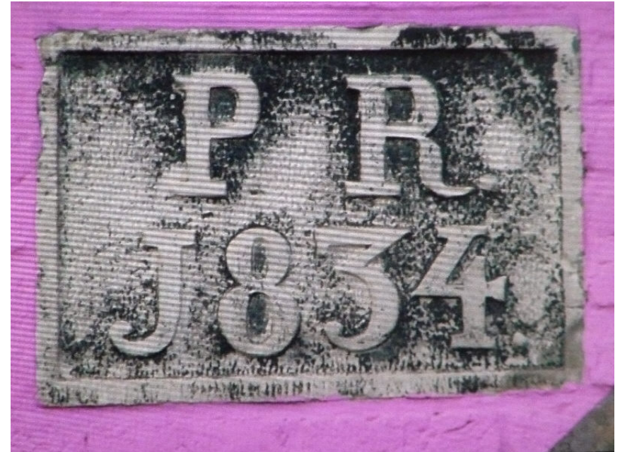
In de fabrieksmuur aan de Boschstraat
